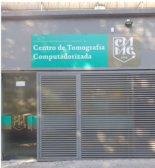
Figura 21 – Fachada do Centro de Tomografia Computadorizada no HUCM
